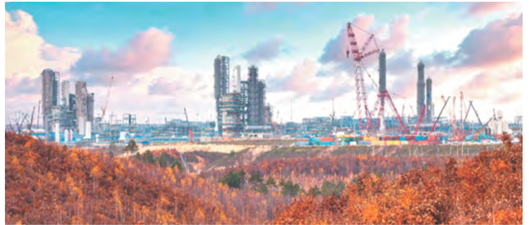
Строительная площадка Амурского газоперерабатывающего завода
