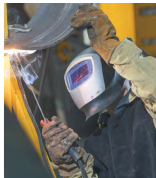
Сварщика газовой часто называют «сварным», а вот сварщика ручной дуговой сварки – «ручником»
