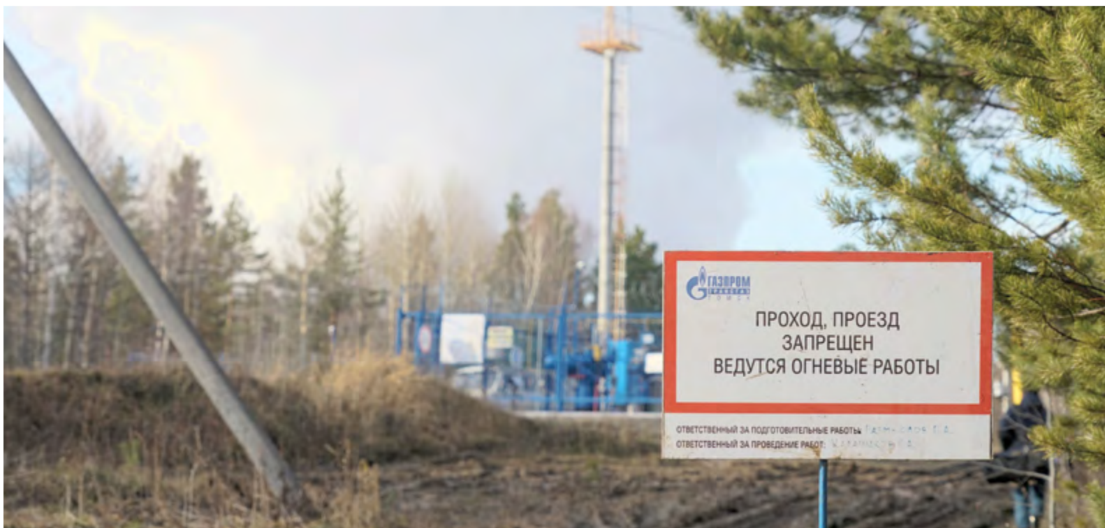
Ремонт дефектов на МГ НГПЗ – ПарABELь – Кузбасс около с. Чажемто
